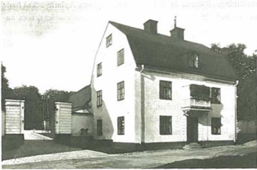
Balkonghuset och porten mot Gaveliusgatan.
