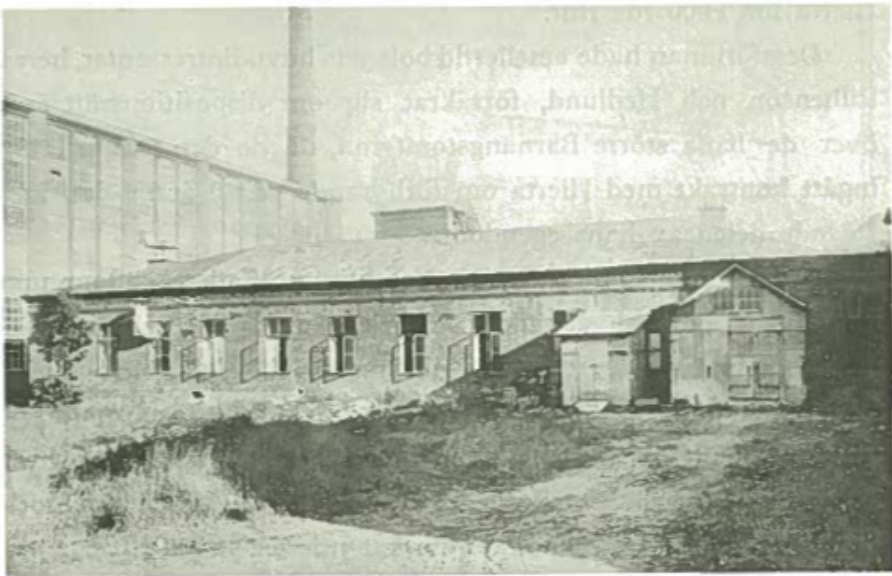
Appreturverk, i en byggnad, som uppförts 1870.
